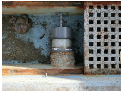
ろ過配管閉止処理
