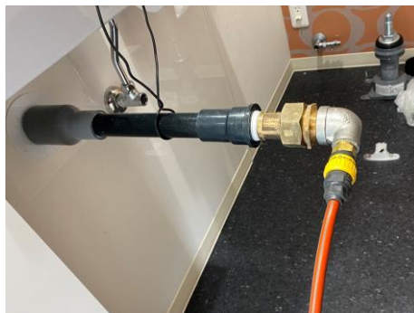
排水管密閉処理
