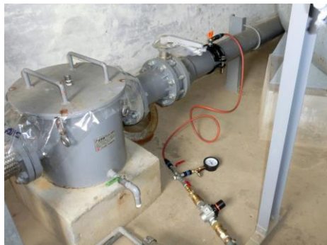
ろ過配管エア充填
