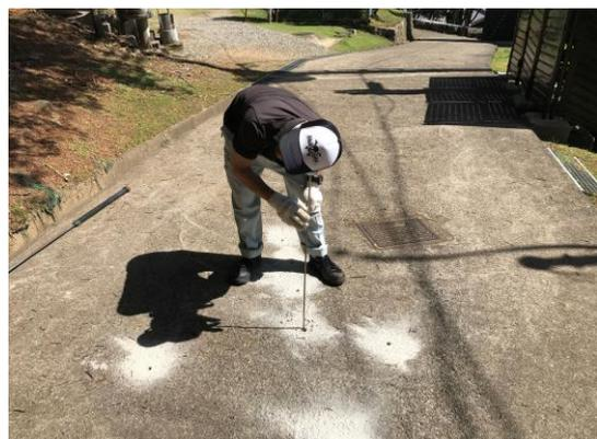
地中音聴で漏水音を確認
