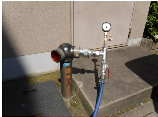
圧力測定を実施
