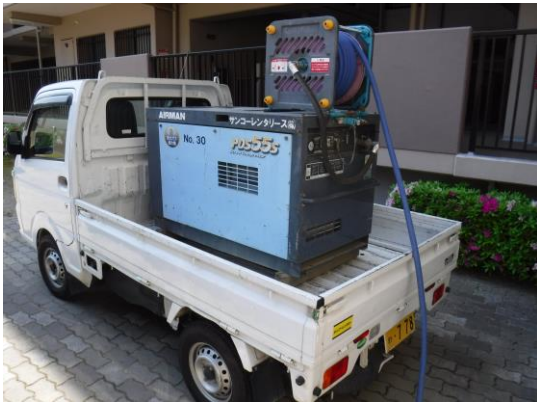
コンプレッサーを送水口に接続し、圧縮空気を充填
