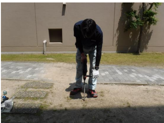
漏水音発生箇所を路面ボーリング
