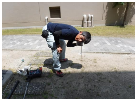
地中音聴で漏水による噴射音を確認 漏水箇所に確定し調査終了
