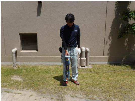
埋設管の位置を確認
