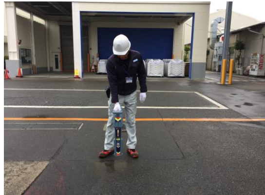
埋設管の位置を確認
