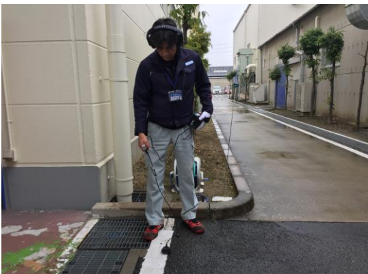
漏水探知機にて路面音聴
