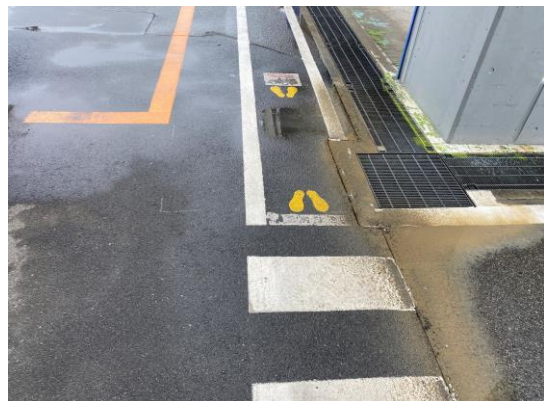
路面上から漏水の水が噴出し漏水箇所を確認
