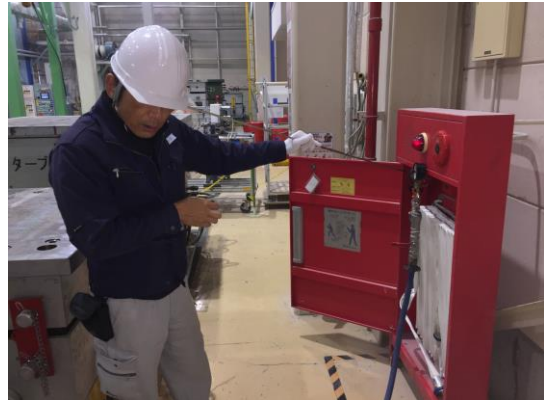
音聴棒にて消火栓の音聴
