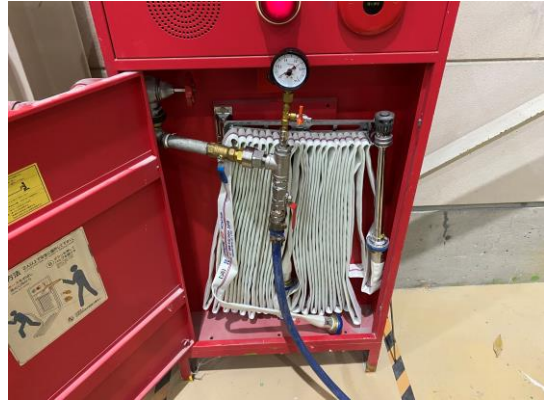
圧力測定を実施
