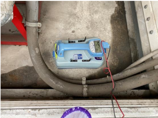
埋設管路調査を実施
