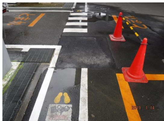
路面復旧 工事無事完了
