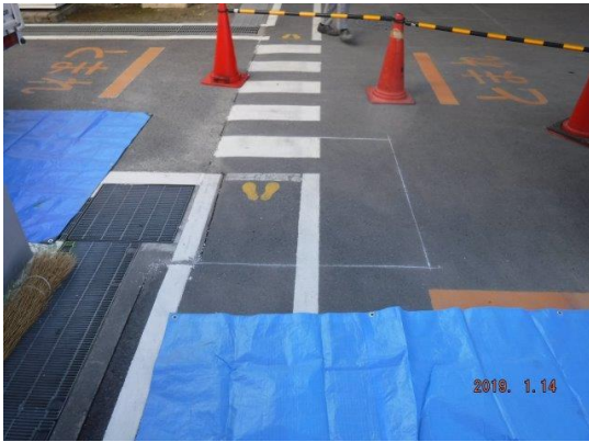
漏水調査を実施した施設の修理工事を実施
