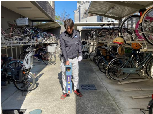
埋設管の位置を確認
