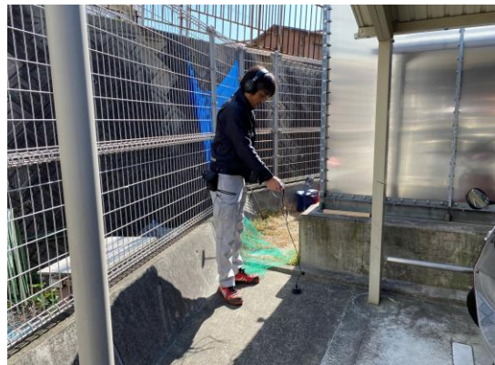
漏水探知機にて路面音聴
