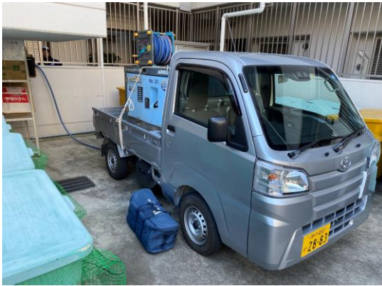
コンプレッサーを消火栓に接続し、圧縮空気を充填
