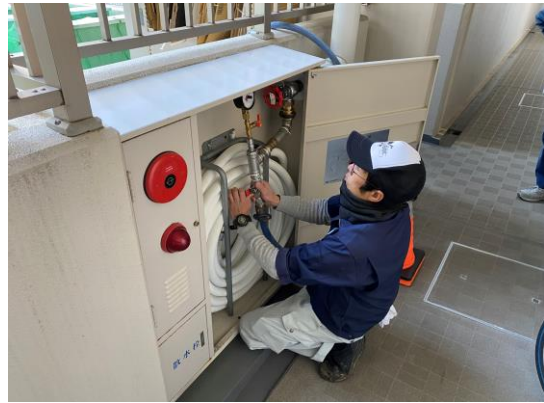
圧力測定を実施
