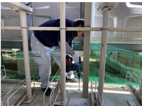
漏水音発生箇所の路面ボーリング
