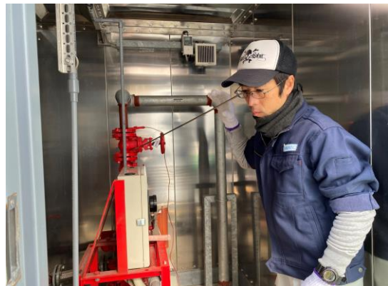
音聴棒にて消火栓の音聴
