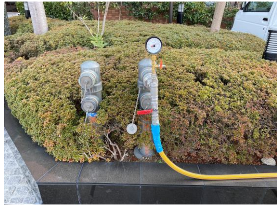
圧力測定を実施
