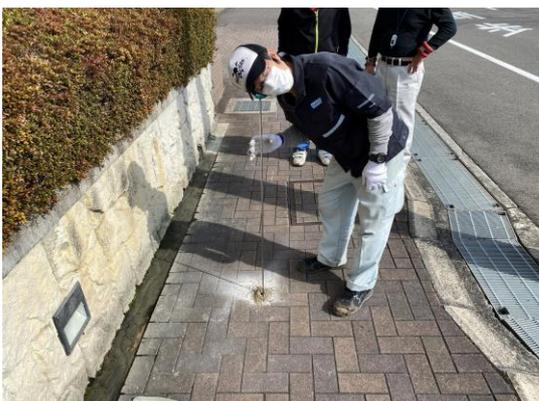
地中音聴し漏水音を確認
