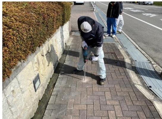
漏水音発生箇所をボーリング
