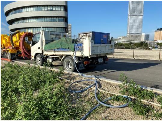
コンプレッサーを散水栓に接続し、圧縮空気を充填
