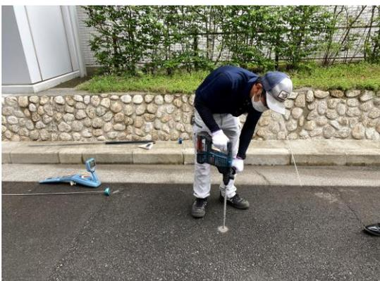
漏水音発生箇所をボーリング
