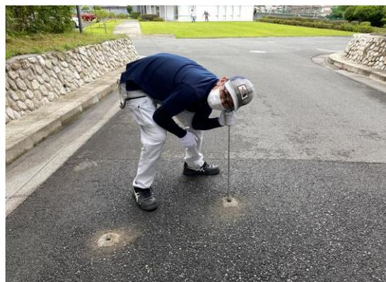
漏水音および圧縮空気の噴出を確認し漏水箇所に確定
