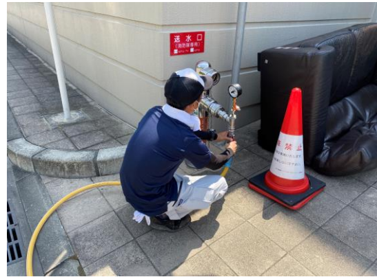
圧力測定を実施
