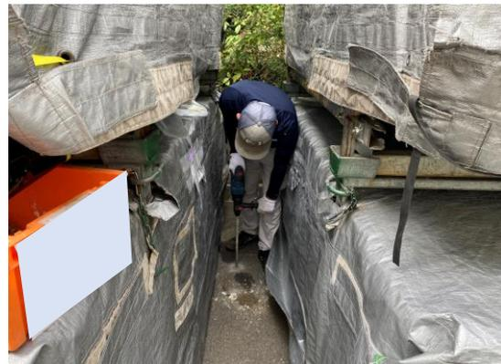
漏水音発生箇所をボーリング
