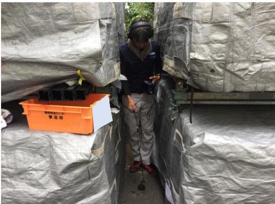
漏水探知器にて路面音聴を実施し、漏水音を確認
