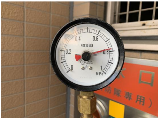
圧力測定を実施
