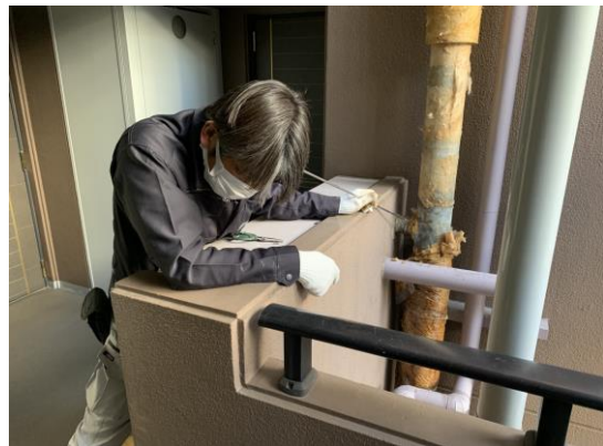
保温材を撤去し直接音聴
