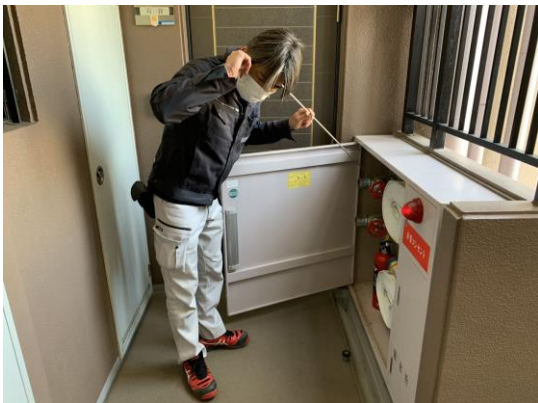
音聴棒にて弁栓音聴を実施し漏水音を確認
