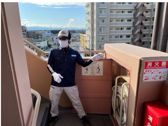
消火栓の音聴
