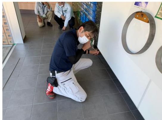
漏水箇所を無事特定し調査を終了
