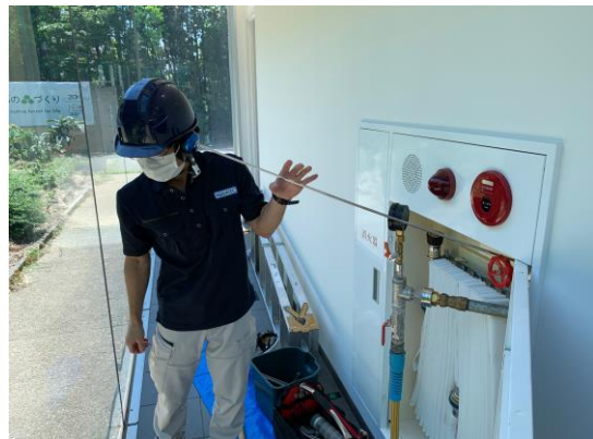
音聴棒にて消火栓の音聴
