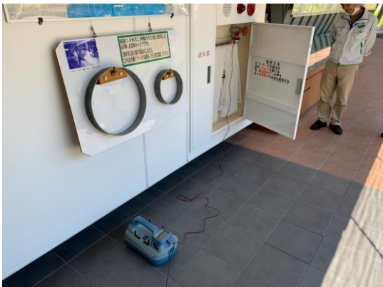
埋設管路調査を実施
