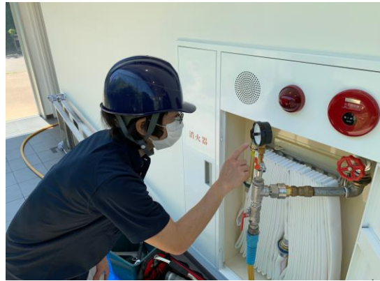
圧力測定を実施
