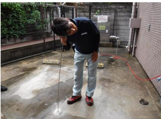
地中音聴で漏水音を確認
