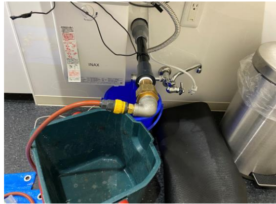
エア充填用治具取付
