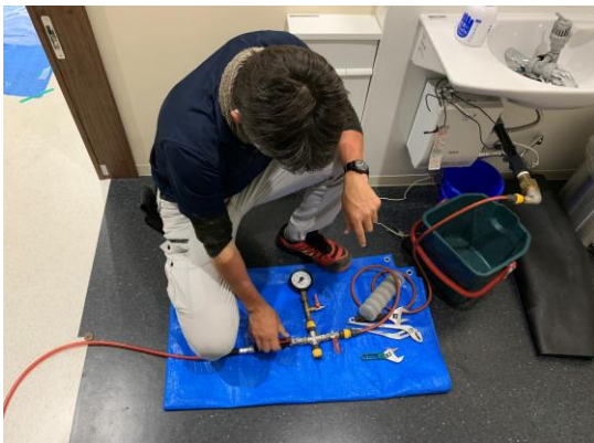
圧力測定を実施
