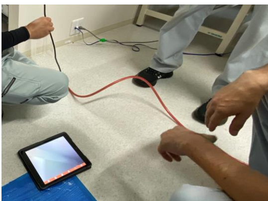
漏水音のあった箇所にカメラを挿入し床下状況の確認
