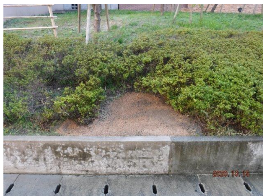
完成 調査1日、工事1日 計2日間で無事完了しました
