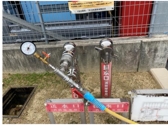
圧力測定を実施
