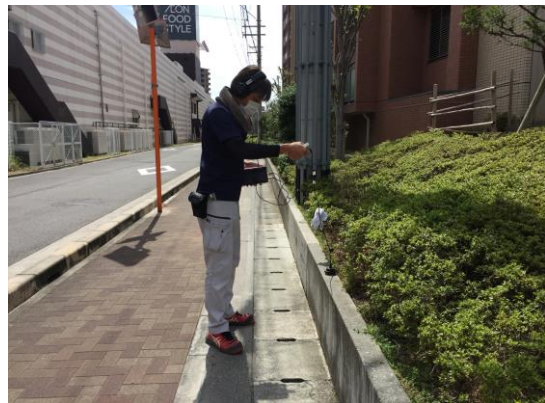
漏水探知機にて路面音聴
