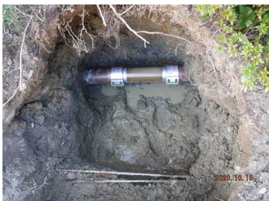
ストラブカップリングにて配管接続
