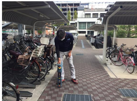
埋設管路調査を実施
