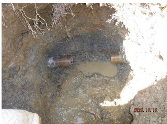
漏水部分の配管を撤去
