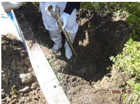
調査により特定した漏水箇所を掘削
