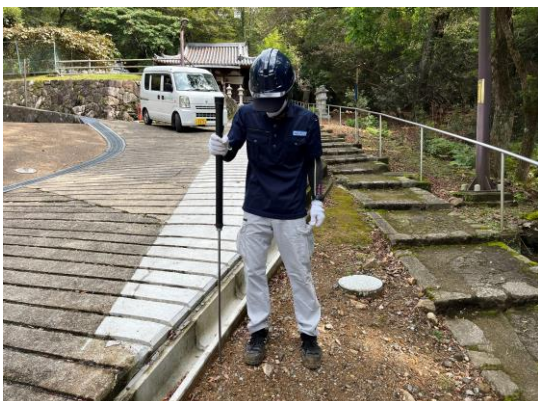
ポーリング作業
