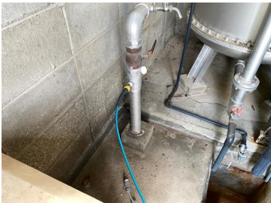
コンプレッサーを配管に接続し圧縮空気を充填
