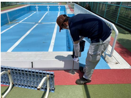
路面ボーリング作業
