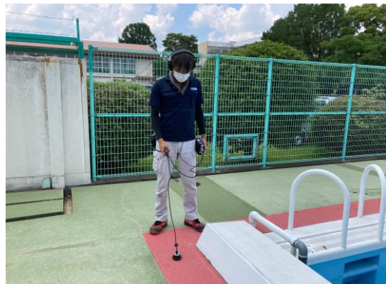
漏水探知機による音聴
