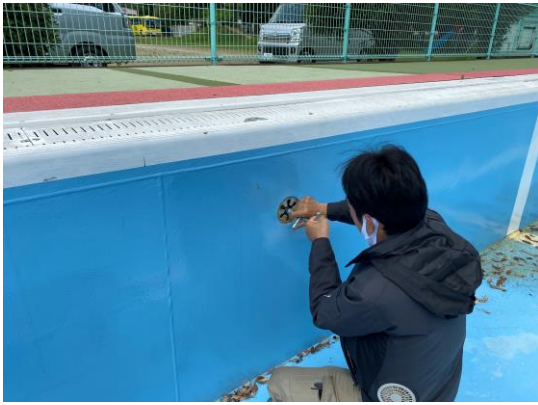
吐出口閉栓作業
