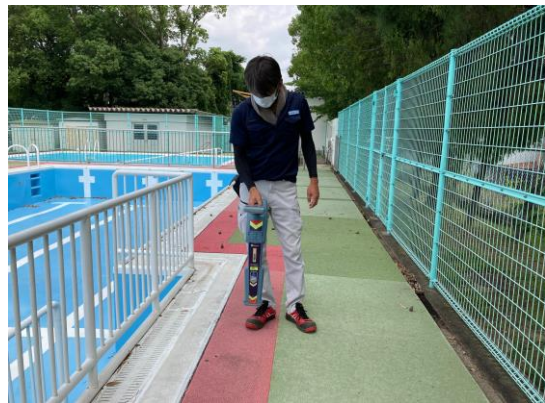
埋設管路調査により配管経路を検出
