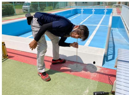
地中音聴により漏水箇所を特定
