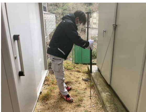
ボーリング作業
