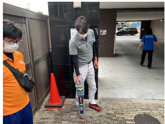
鉄管探知機による埋設管探査
