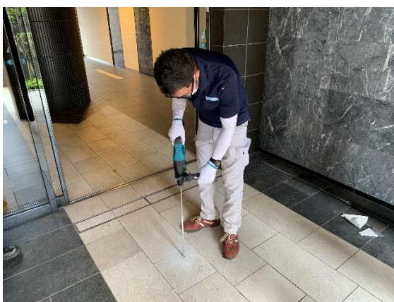
ボーリング作業
