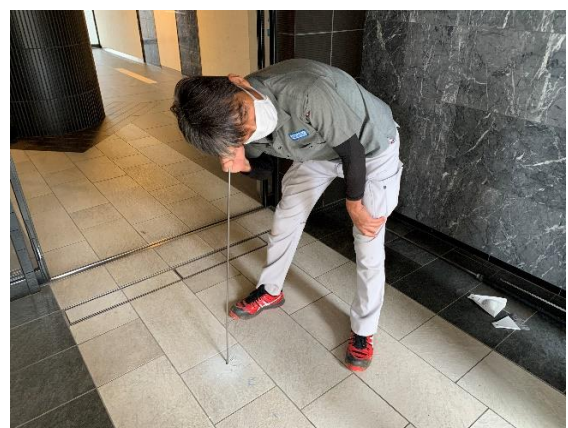
地中音聴により漏水箇所を特定
