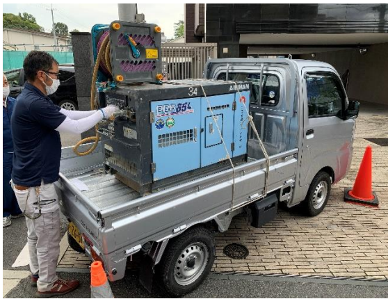
コンプレッサーを送水口に接続
