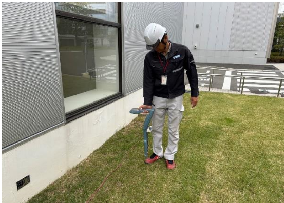
鉄管探知器による管路調査
