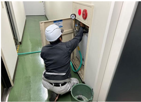
コンプレッサーを消火栓に接続しエアを充填
