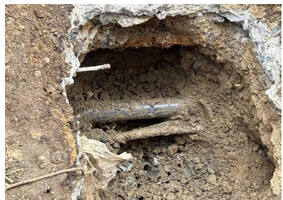
コンクリート下 埋設部にて漏水
