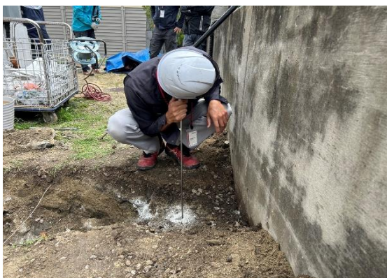
地中音聴により漏水箇所を特定
